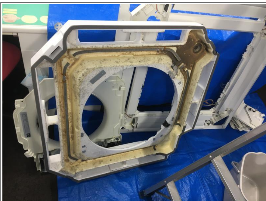
ドレンパネル(施工前)
